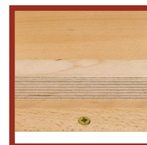
[4] zajištění bočnice vruty
